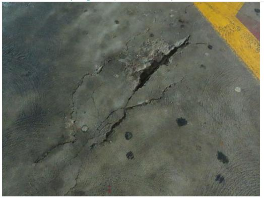
Photo 1.22- Isolated slab edge spall, Pier level (MM1-129)
